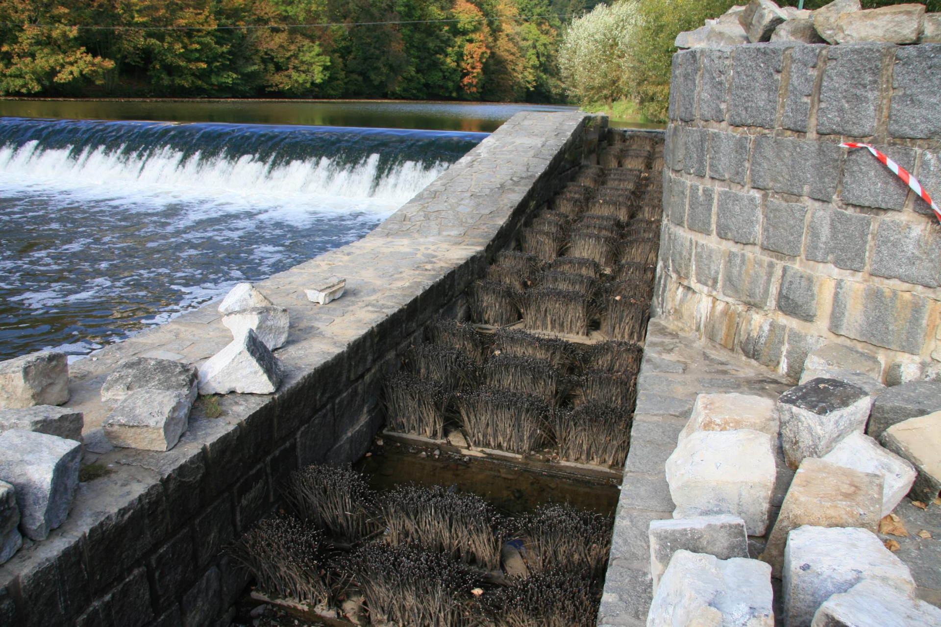
Kartáčový rybí přechod – varianta pro vodácky využívaná koryta
