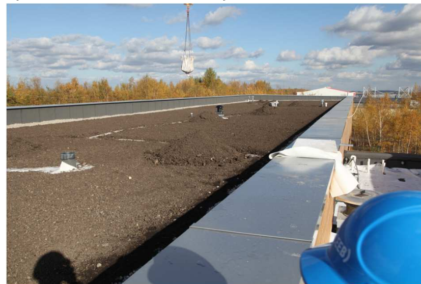
výstavba zel. střechy UCEEB, ČVUT
