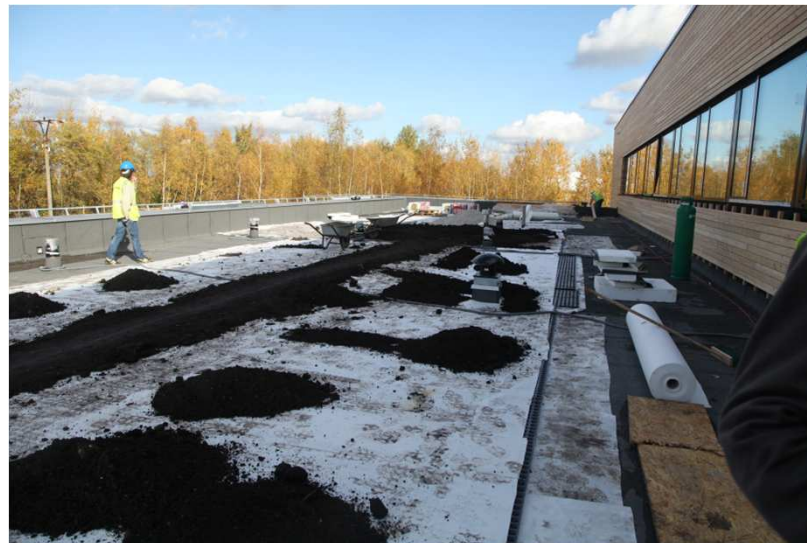
výstavba zel. střechy UCEEB, ČVUT
